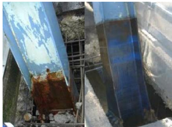
図12 CFRPストランドシートによる橋梁鉄鋼部材の補修例(左補修前、右補修後)
