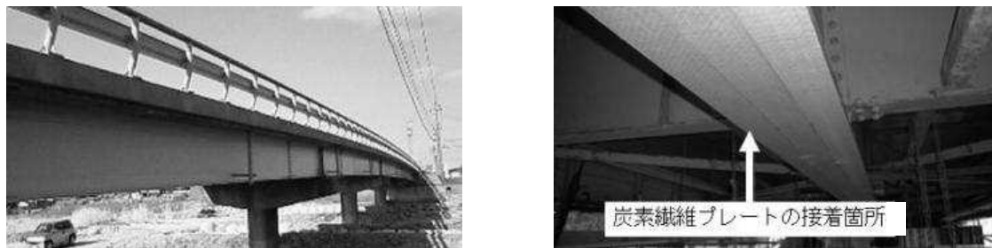
図14 大名橋（鳥取県）の高弾性CFRPプレート補強
