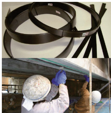
予め工場成型した炭素繊維複合材料（CFRP）製品 インフラ構造物の補修補強が可能に
