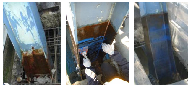
高弾性率炭素繊維による鋼製橋の補強・補修
