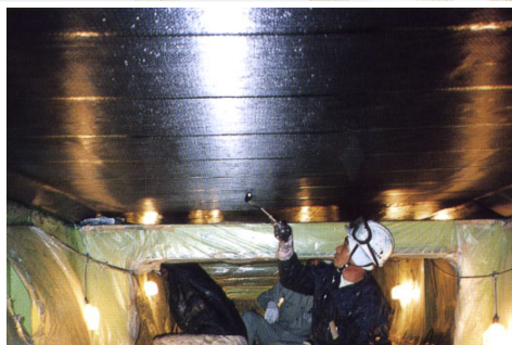
炭素繊維シートによる床版の補修・補強
